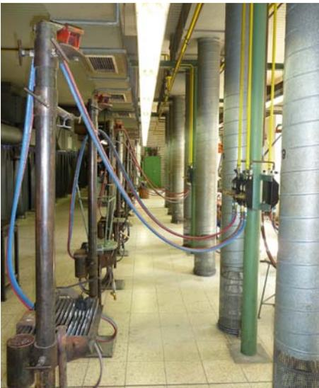
**Bild 7** Schweißerei mit Schichtlüftung
